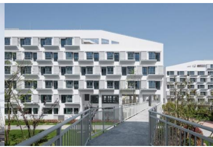
住宅建筑（上海龙南佳苑）
