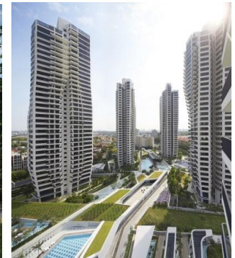
公建化立面居住建筑（丽敦豪邸）
