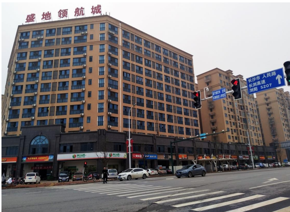
沿街透视实景
