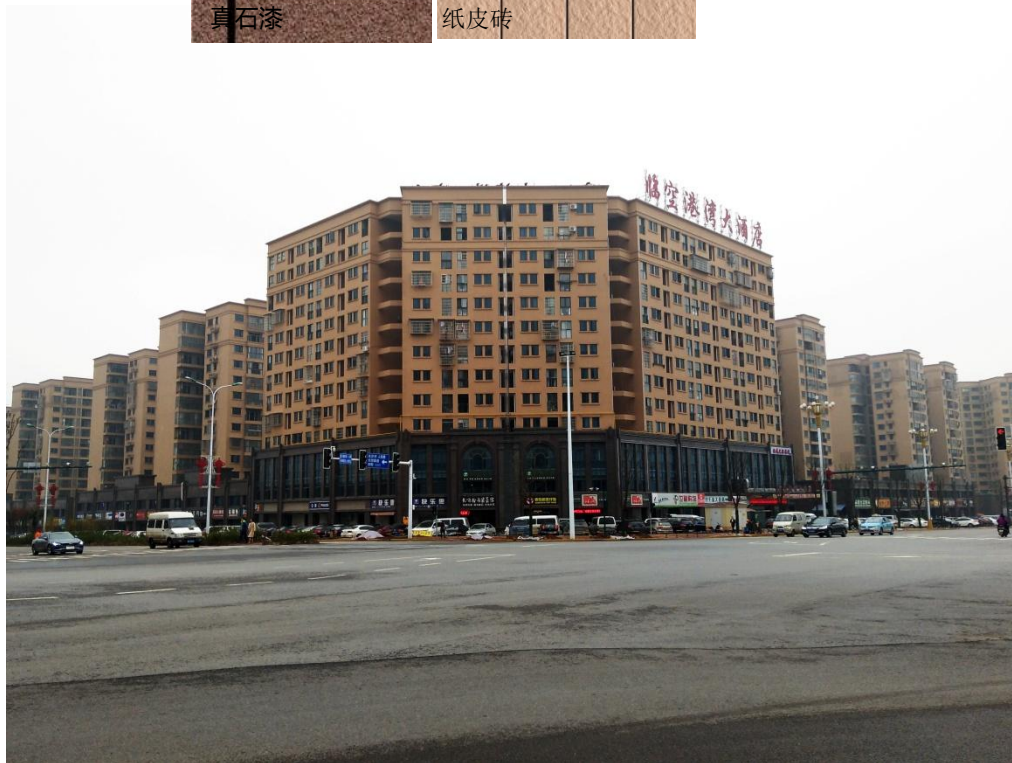
沿街透视实景
